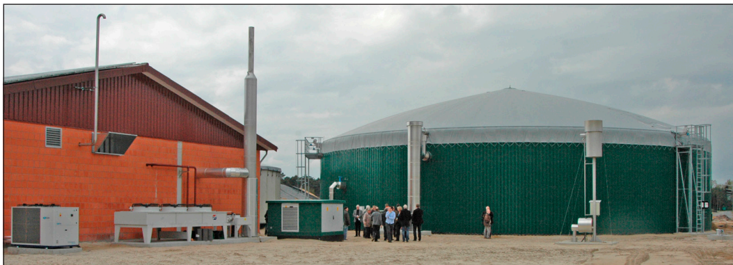
Ende 2011 hat die Saergas GmbH & Co. KG ihre 1,05-MW-Biogasanlage auf dem Gelände des Bioenergieparks in Betrieb genommen. Bis 2014 sollen eine weitere Biogasanlage, eine Bioabfallbehandlungsanlage, sieben Windkraftanlagen und ein Photovoltaikpark folgen. Fotos: Brockmann-Könemann
